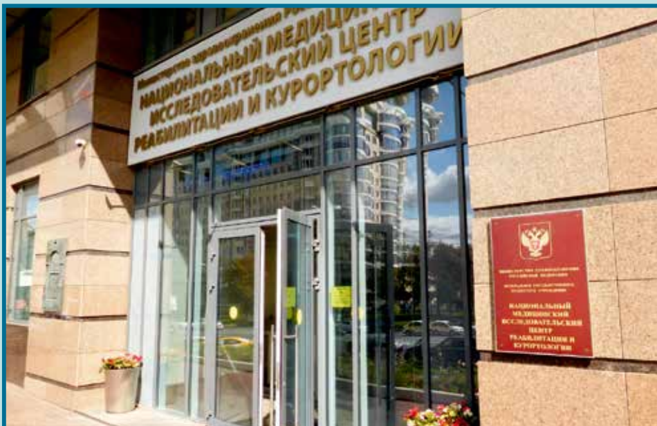
Научно-клинический центр на Новом Арбате /г. Москва/
