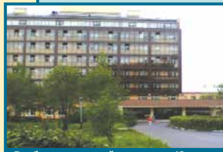
Реабилитационный комплекс «Юдино» /Московская область/
